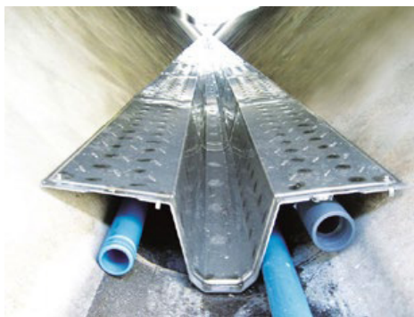
مبدل حرارتی در فاضلاب دارای کانال هوای خشک، مناسب برای DIN 400.
